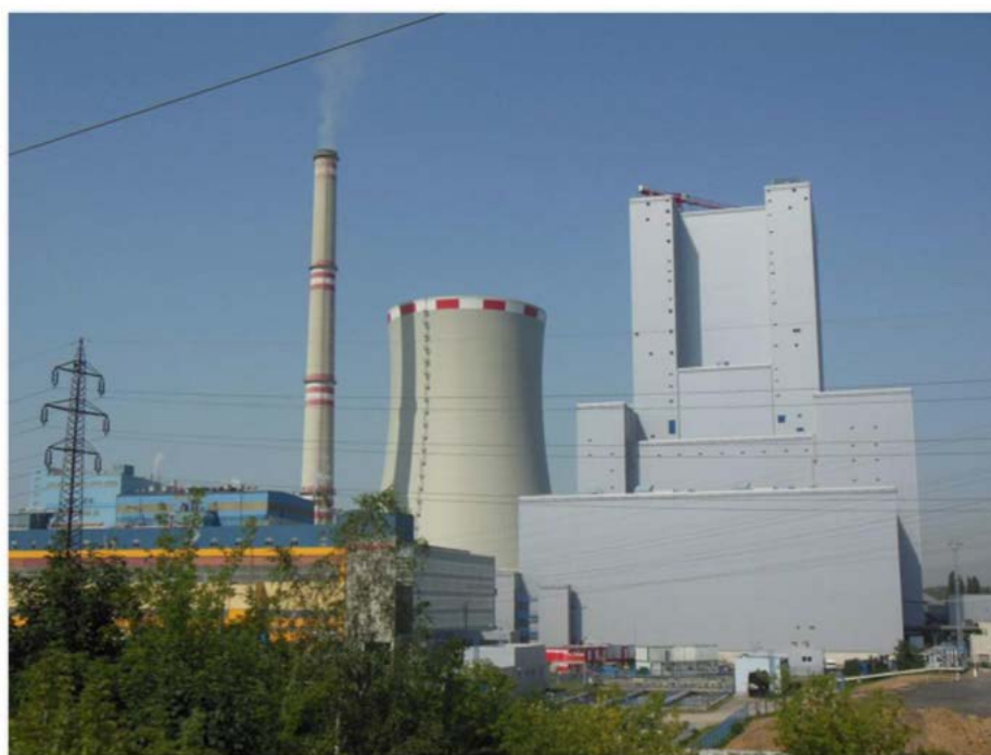
Obrázek 1. Nový blok hnědohelné elektrárny Ledvice
